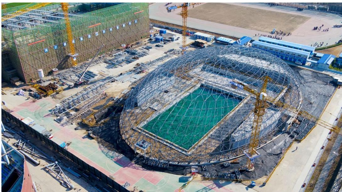
3月21日，由钢结构分公司施工的跨度60米、长度200余米、面积超13000平方米的大跨度网架（北）顶升到位，展示了集团的实力与风采。（下图）
